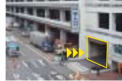
車入口 (B棟南入口)
